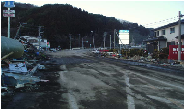
道路啓開 作業後
