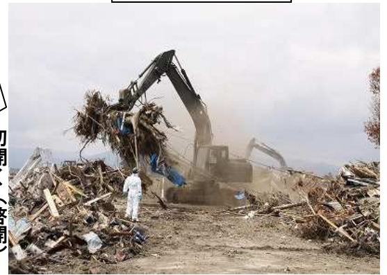
道路啓開 作業中
